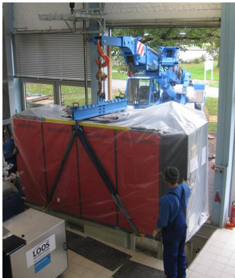
Abbildung 2: Einbau eines Blockheizkraftwerks
